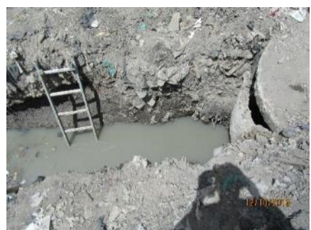
Изображение Н3с. Возможна поломка трубы; стоячая вода без течения; возможно химическое загрязнение
